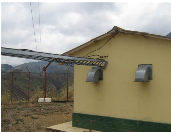
SALIDA EXTRACTORES DE AIRE
