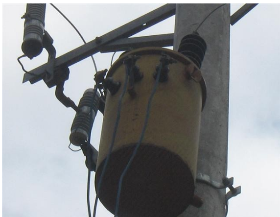
TRANSFORMADOR 10KVA ESTACION
