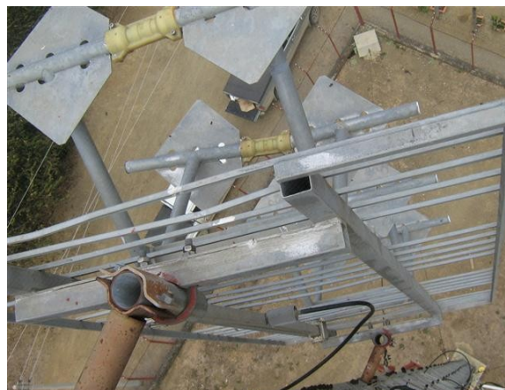
ANTENA PANEL DOS DIPOLOS
