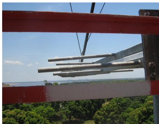
Antena Yagi Cara A
