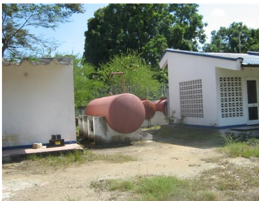
Tanques ACPM planta telecom
