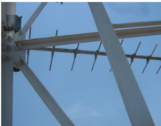
Antena Yagi V3
