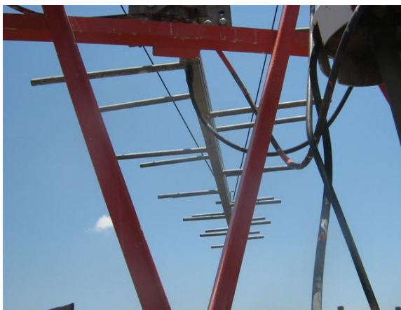
Antena yagi Cara D
