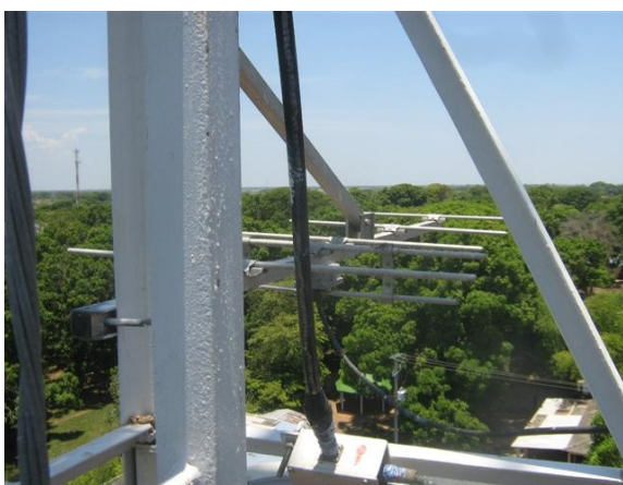
Antena Yagi V4
