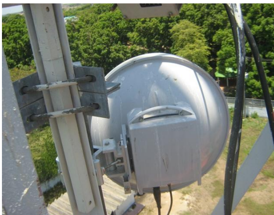
Antena Microondas V4
