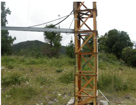
Escalerilla horizontal a estación
