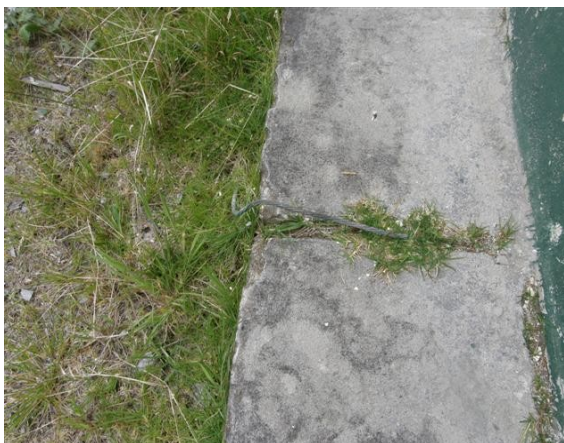
Tierra que va a la parabólica
