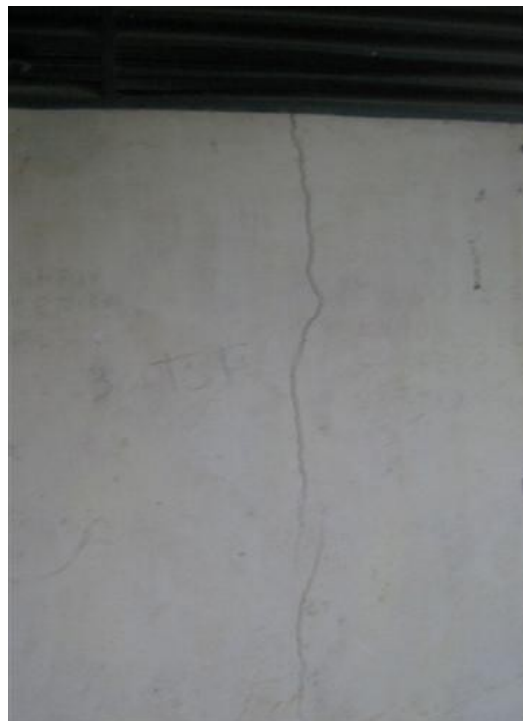
Fisura en pared posterior de estación
