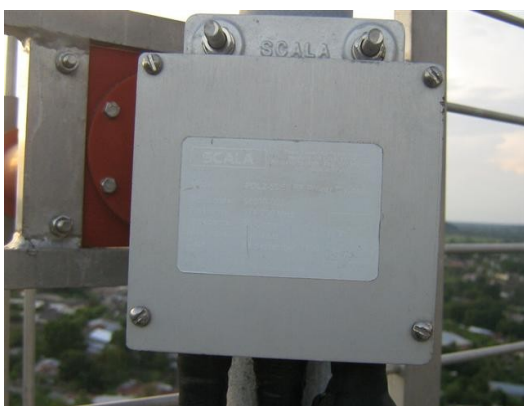
Distribuidor Principal sistema radiante
