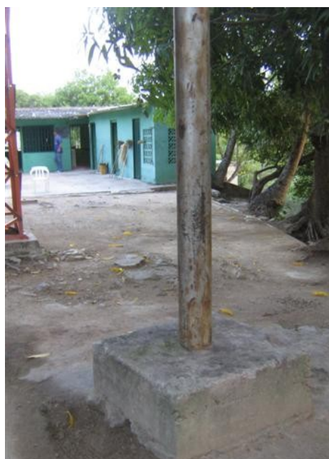
mástil antena parabólica sin sistema de tierra
