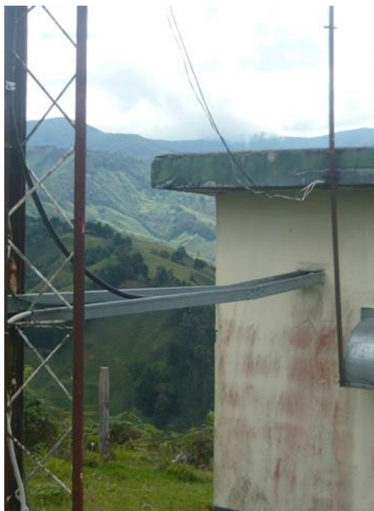
Escalerilla horizontal hacia cuarto de equipos
