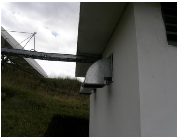
Escalerilla y ductos de ventilación
