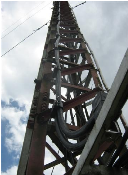
Paso de cables en torre
