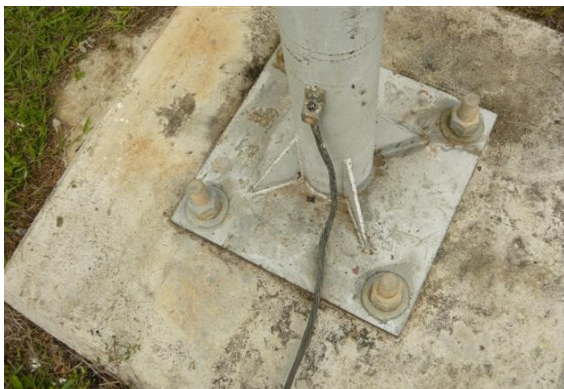
Base y sistema de tierra anena satelital
