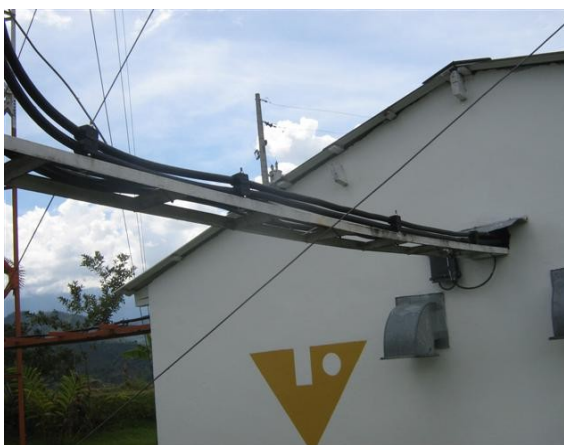
Escalerilla horizontal hacia salón de equipos
