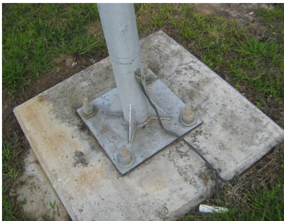
Sistema de tierra antenna satelital
