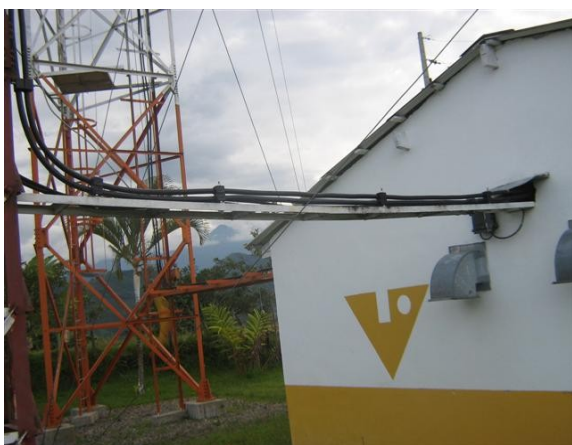
Escalerilla torre – salón de equipos
