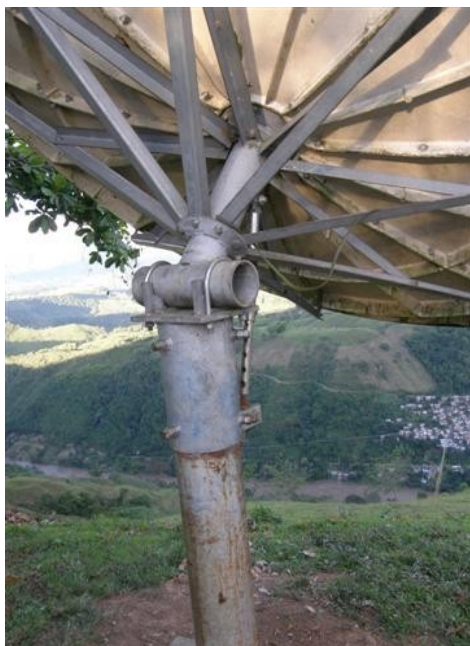
Soporte antena parabólica
