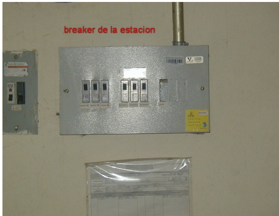
Breakers de la estación
