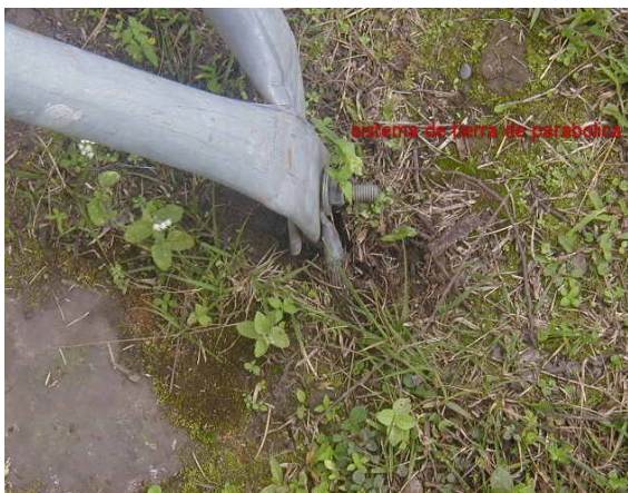
Sistema de tierra de la parabólica
