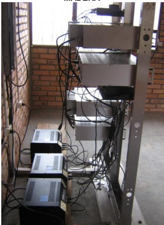
EQUIPOS TX Y ACONDICIONADORES DE LINEA
