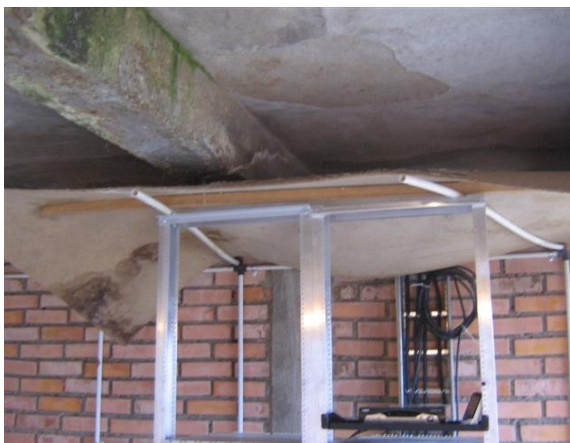
TECHO Y FILTRACION DE AGUA A SALON EQUIPOS
