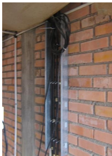
ESCALERILLA Y RECORRIDO LINAS DE TX
