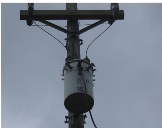
TRANSFORMADOR DE ESTACION
