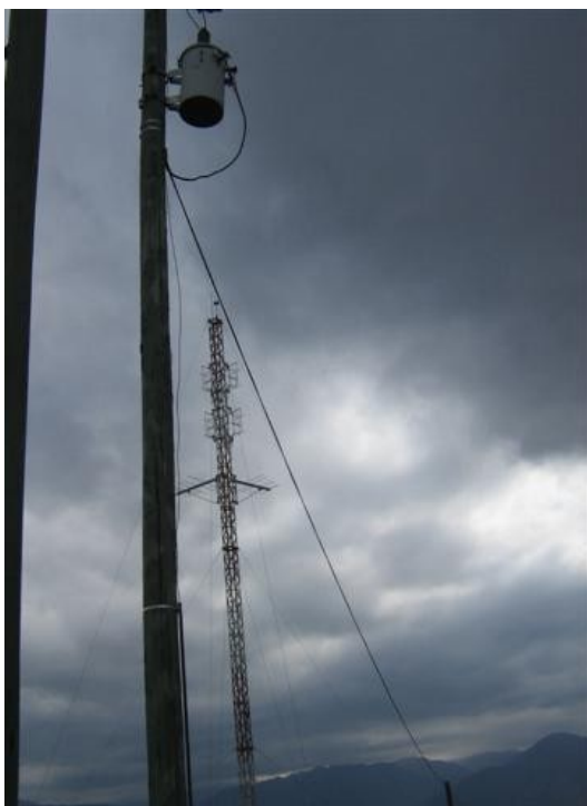
ANCLAJE TRANSFORMADOR A POSTE DE MADERA
