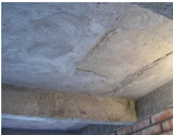
TECHO CON FILTRACIONES DE AGUA
