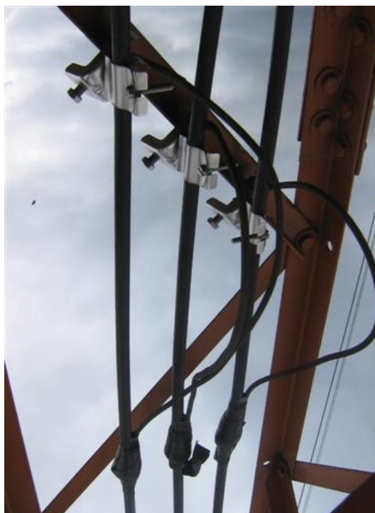
LINEAS DE TX CONECTADAS A TIERRA
