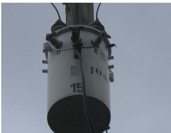
TRANSFORMADOR DE ESTACION 15 KVA
