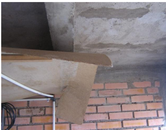
TECHO CON FILTRACIONES DE AGUA
