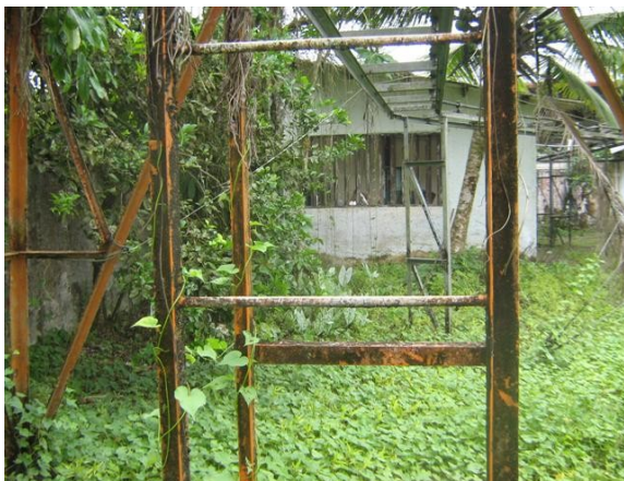
Escalerilla vertical y estado pintura
