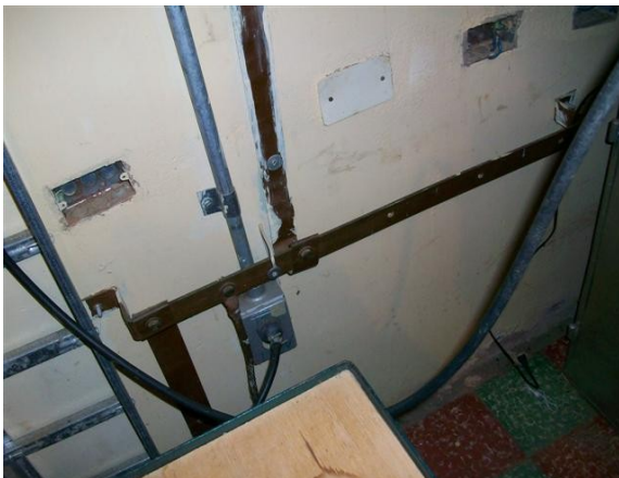
Barra de tierra salón de equipos
