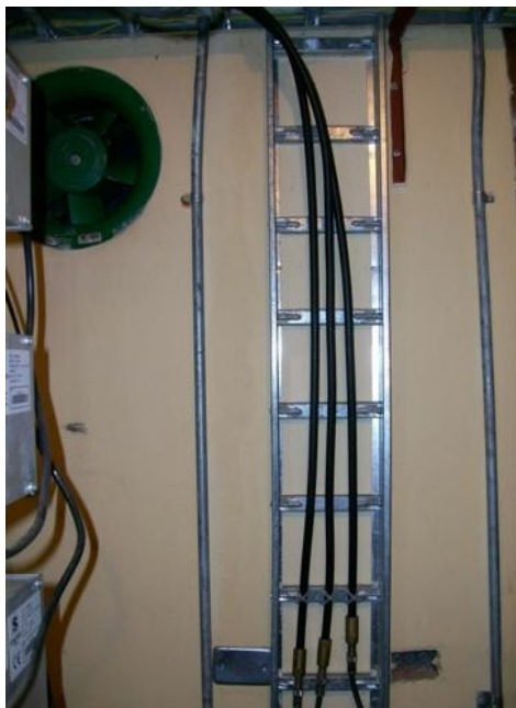
Escalerilla vertical salón de equipos
