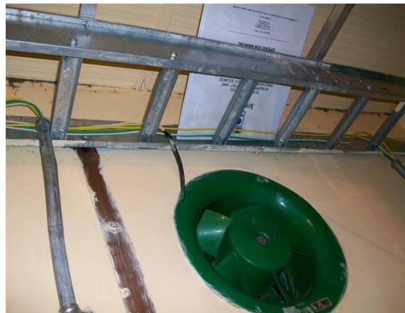
Escalerilla y extractor salón de equipos
