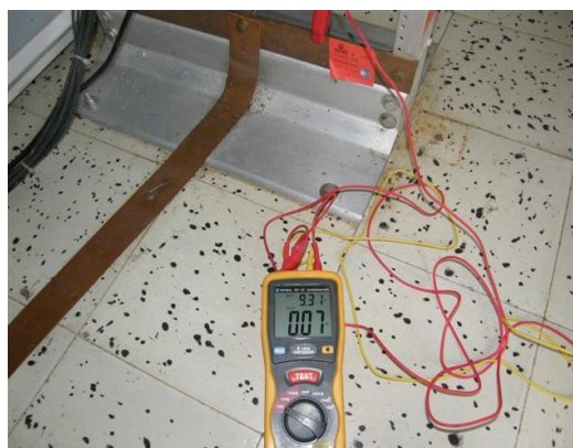
Medida de tierra en salón de equipos
