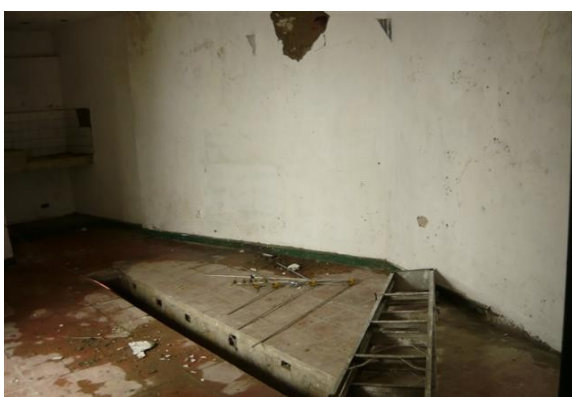
Humedad salón de equipos
