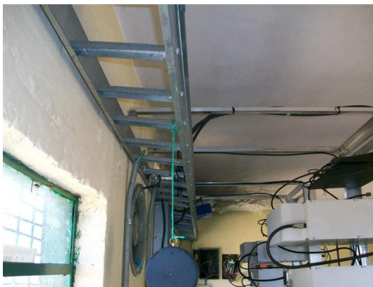
Escalerilla interior salón de equipos
