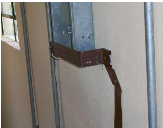
Platina de tierra salón de equipos
