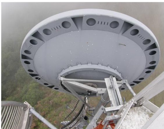
Antena parabólica
