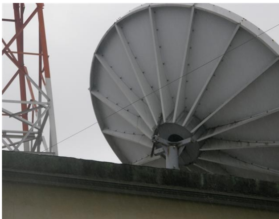
Detalle antena satelital
