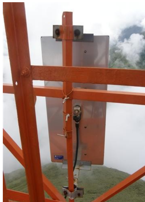
Antena panel cara B
