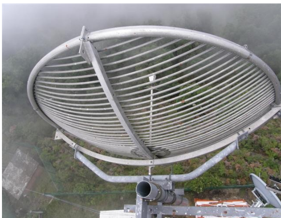
Antena parabólica
