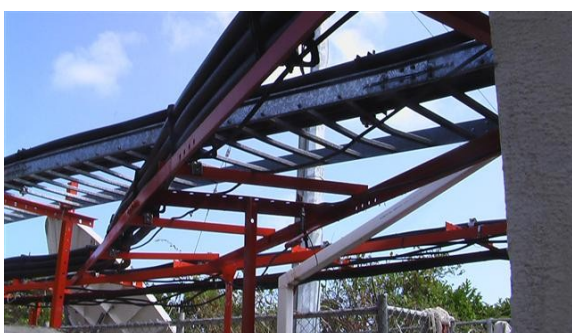
escalerilla y recorrido de los cables
