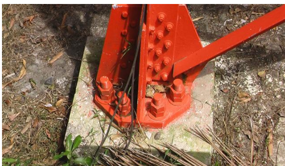
sistema de puesta a tierra torre
