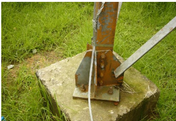
Sistema de puesta a tierra de la torre
