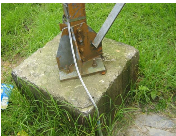
Sistema de puesta a tierra de la torre 1
