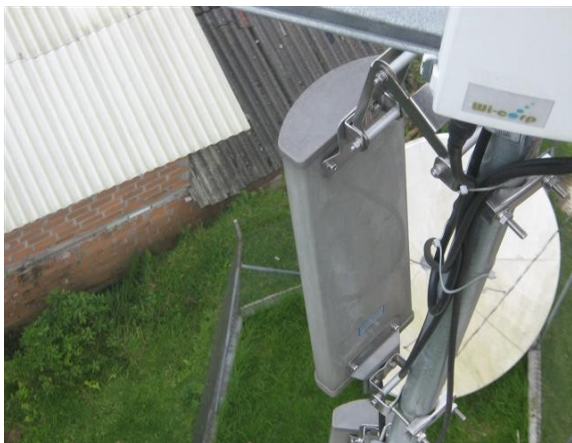
Antena panel - Vértice 3
