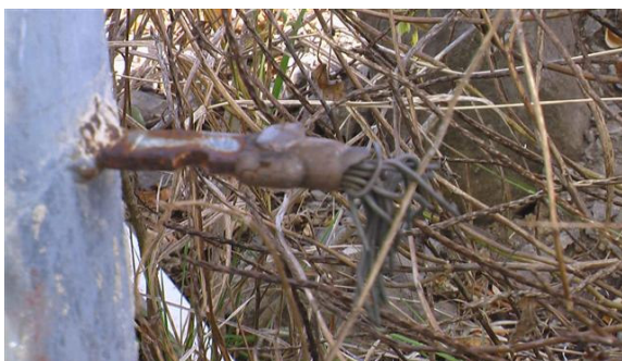
Puesta a tierra antena parabólica
