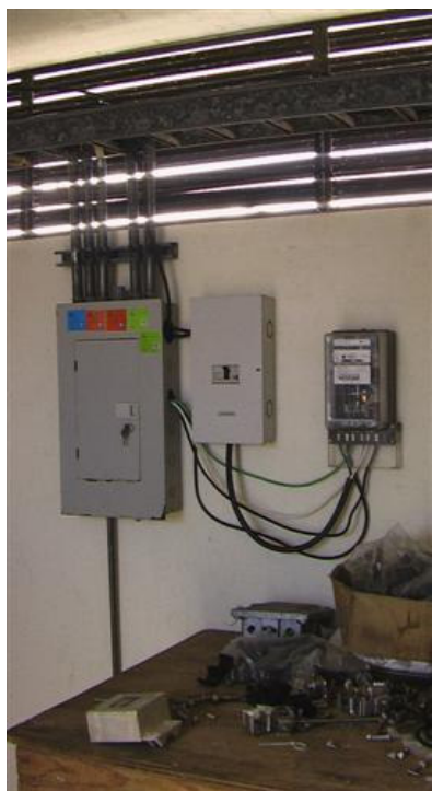
Contador y cajas breakers
