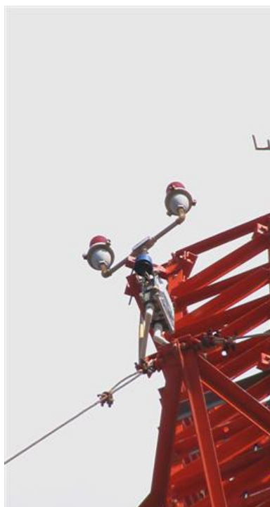
Detalle pintura y luces de obstrucción
