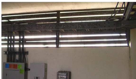
Ventilación y escalerilla interna
