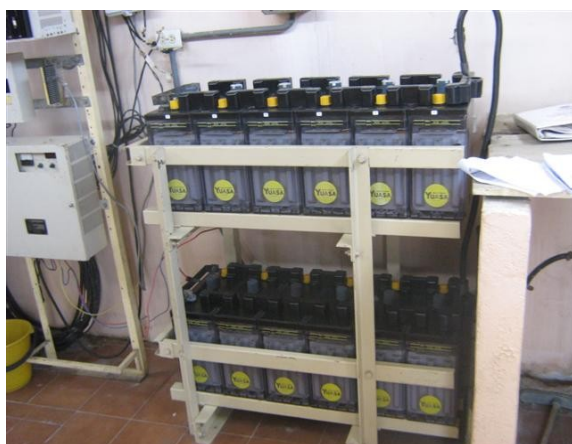
Baterías equipos de radio
