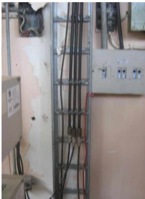
Escalerilla interna y líneas de transmisión
