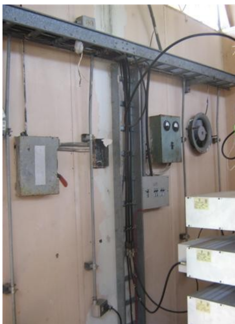
Escalerilla interna salón de equipos
