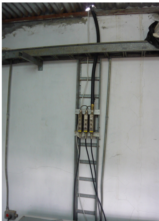
Escalerilla dentro de la estación, triplexores
