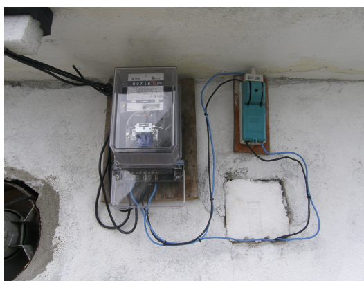
Contador de la estación
