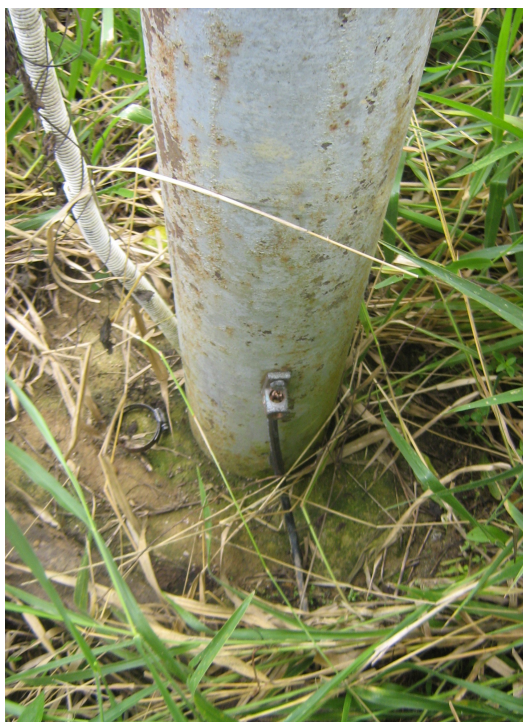
Sistema de tierra Antena satelital
