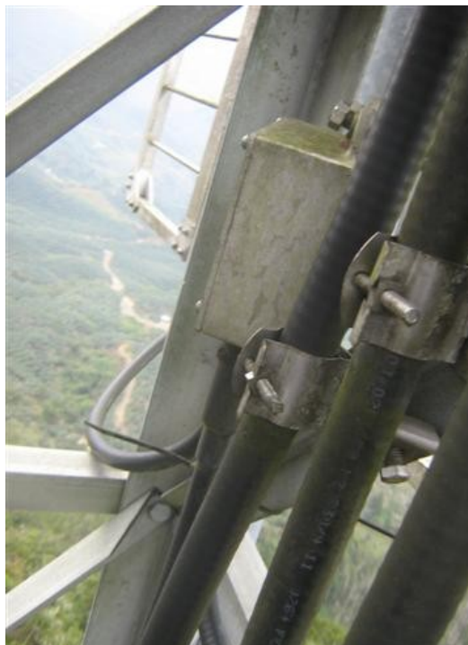
Distribuidor y líneas de transmisión
