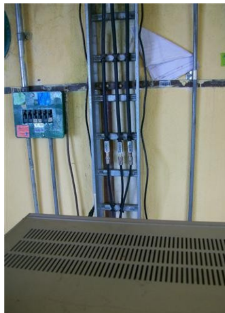
Escalerilla vertical salón de equipos
