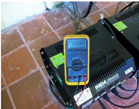
Medida tensión de salida regulador C1
