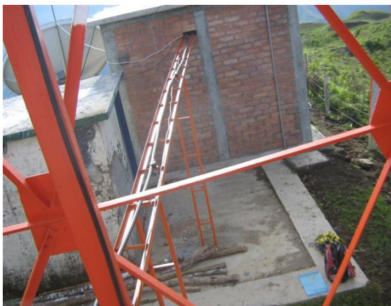
Escalerilla horizontal al salón de equipos
