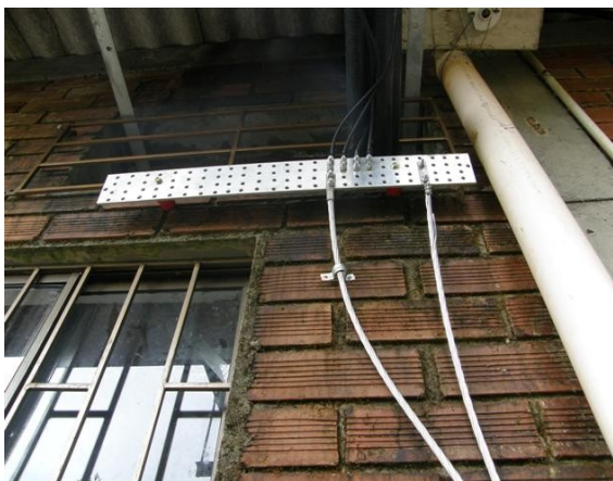
Puesta a tierra del salón de equipos
