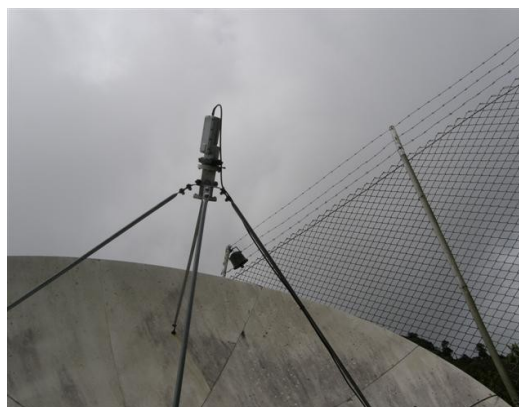
LNB de la Parabólica
