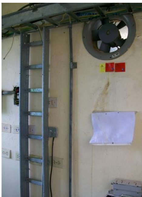
Escalerilla vertical salón de equipos
