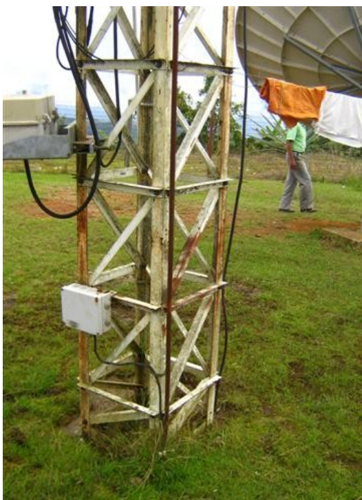
Sección angulo base y detalle de pintura
