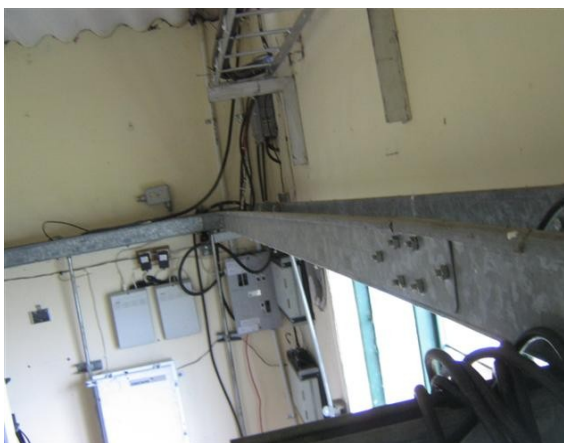
Escalerilla horizontal interior salón de equipos
