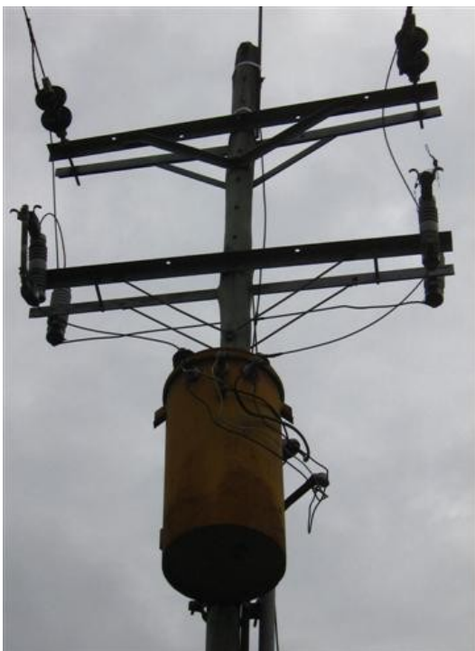
transformador estación
