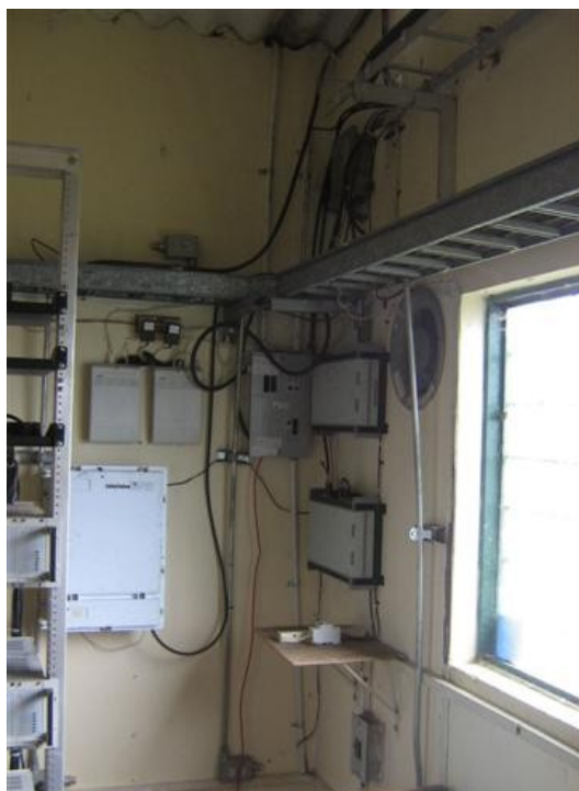
Escalerillas y equipos telecom
