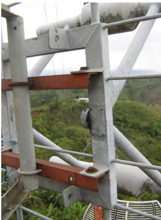
Antena panel dos dipolos fuera de servicio
