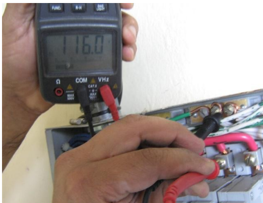
Medición voltaje fase R
