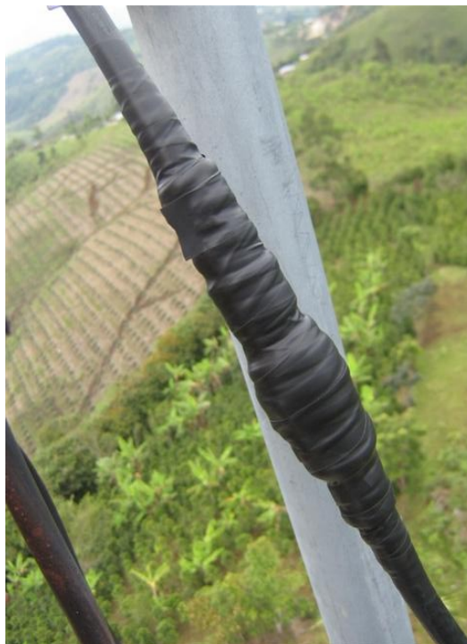
Conector antenna yagi canal uno
