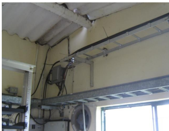
Escalerillas Telecom (arriba) y RTVC (abajo)
