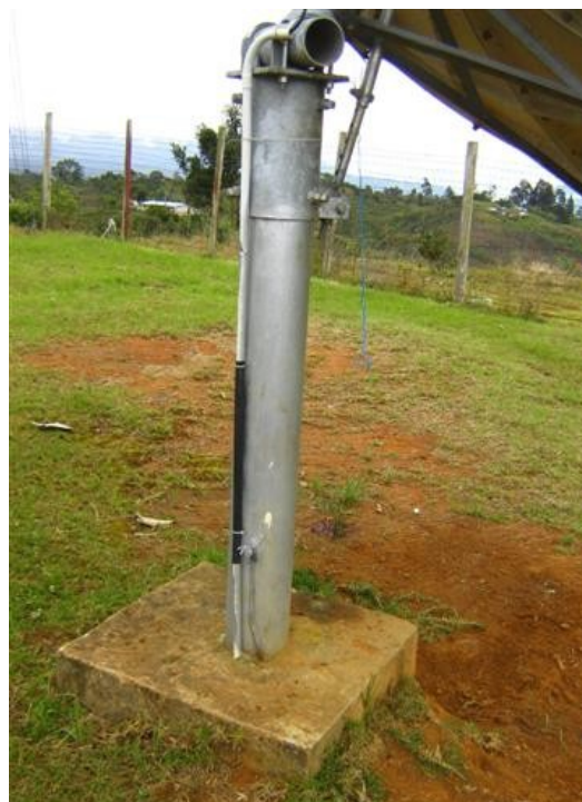
Mástil antenna parabólica
