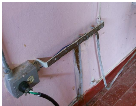
Platina de tierra salón de equipos
