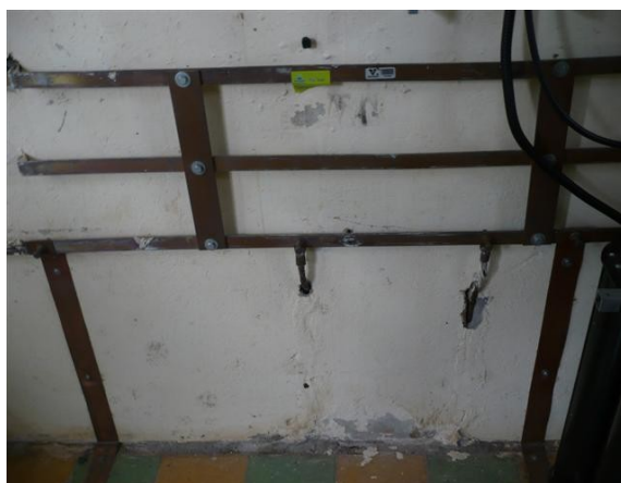
Barrajes sistema de puesta a tierra equipos
