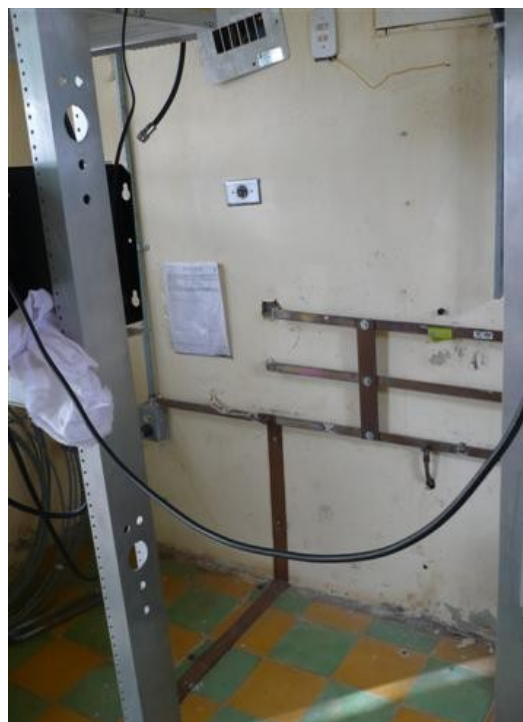
Barrajes sistema de puesta a tierra
