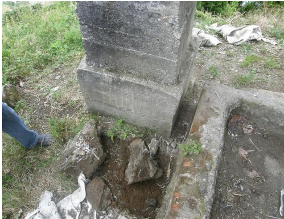
Base parabólica sin tierras
