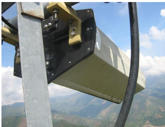
Antena scala panel V2 (teleantioquia)
