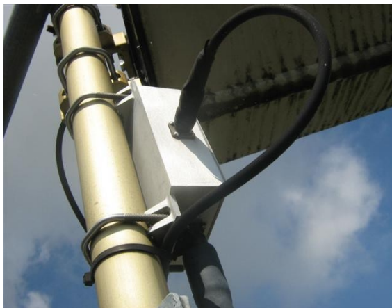
Distribuidor antenas panel
