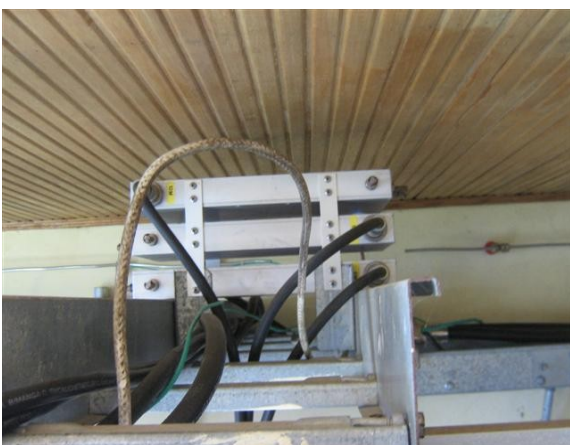
Triplexor para sistema radiante
