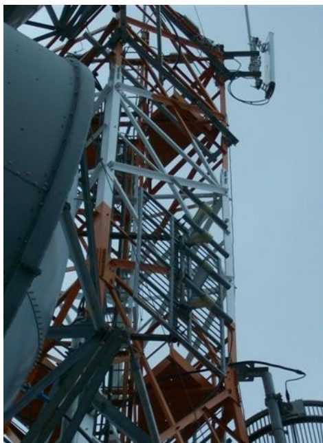
Antena panel RTVC (canales triplexados)
