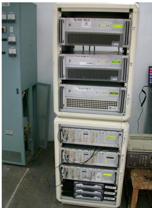
Transmisores y receptores satelitales de C1, SC y SI
