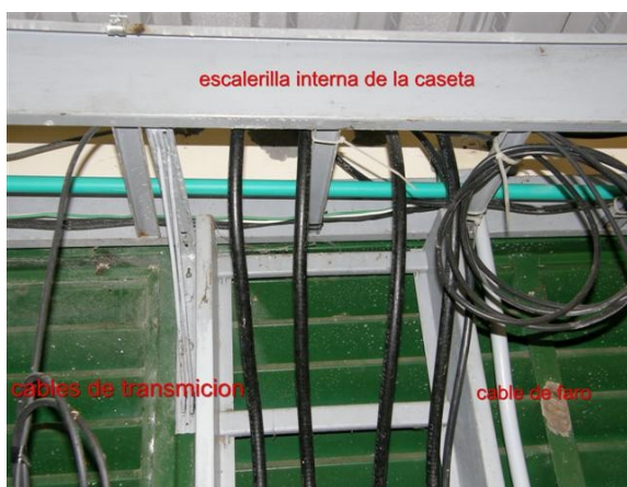
Escalerilla y lineas de transmisi3n
