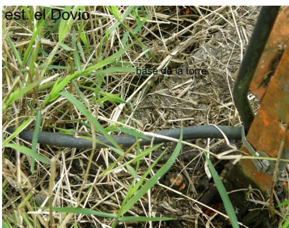
Sistema de puesta a tierra de la torre
