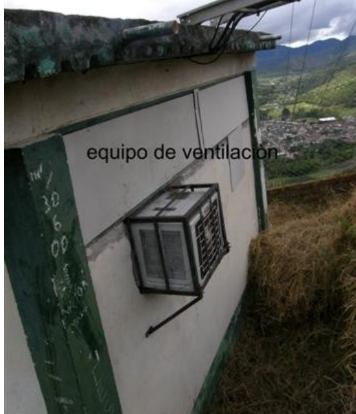
Aire acondicionado salón de equipos
