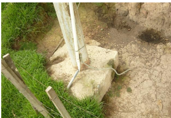
Sistema de Puesta a Tierra Antena Satelital
