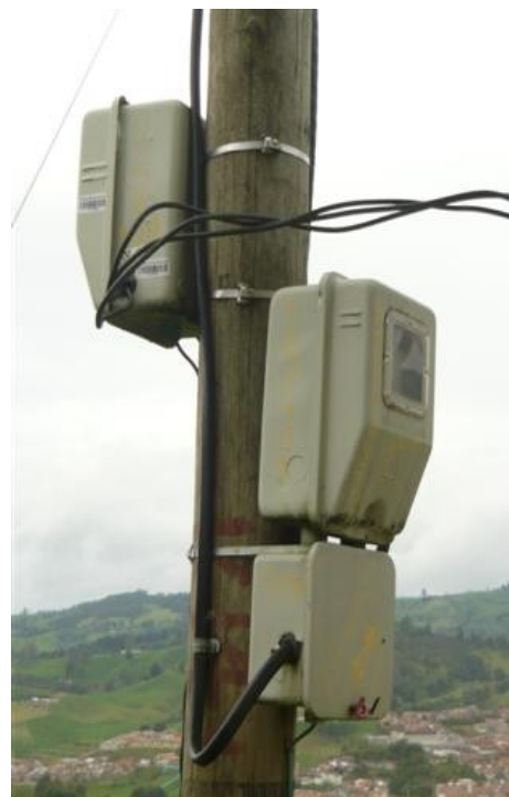
Contador de Energía (1)
