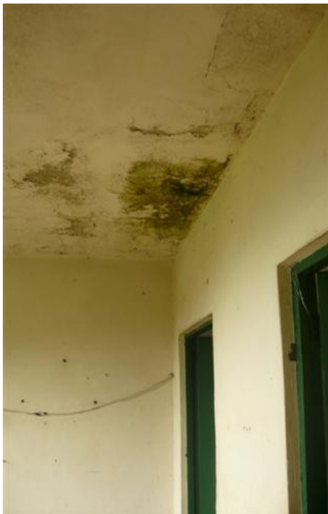
Humedad en cuarto de equipos
