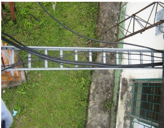
Escalerilla horizontal y recorrido de cables
