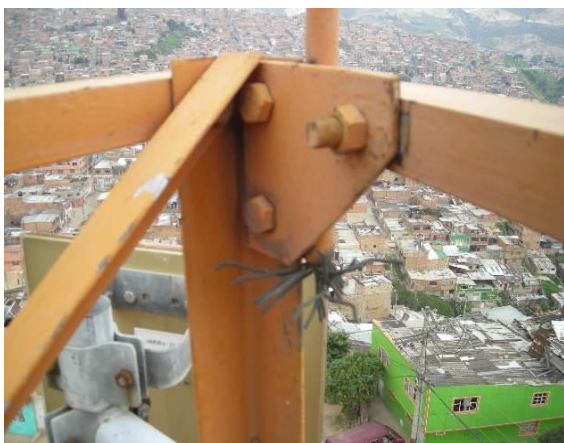
Cable inservible pararrayos
