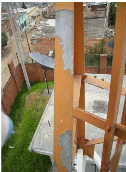
Detalle estado de pintura torre
