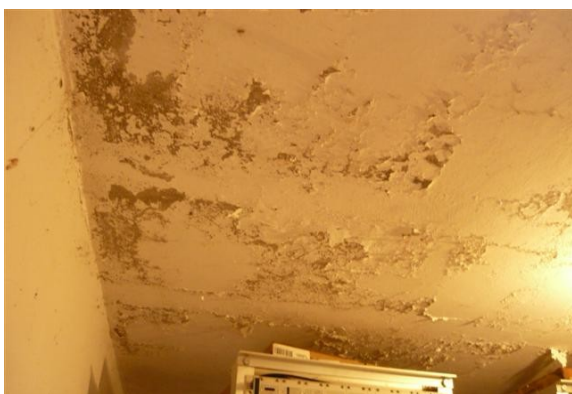
Humedad salón de equipos
