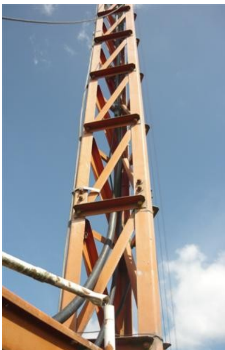
Paso de feeders en torre
