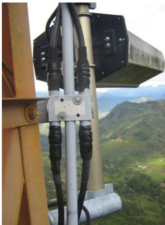
Distribuidor Antenas,
