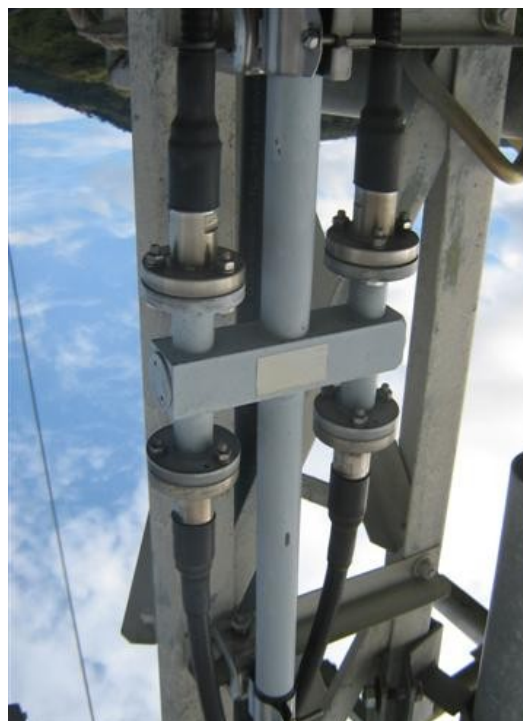
Distribuidor de antenas
