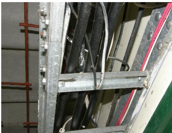
Escalerilla interna con cables
