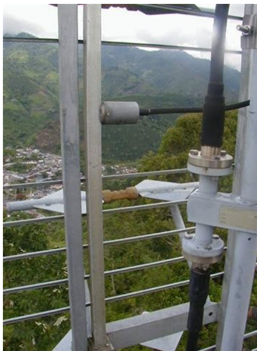
Distribuidor de antena panel
