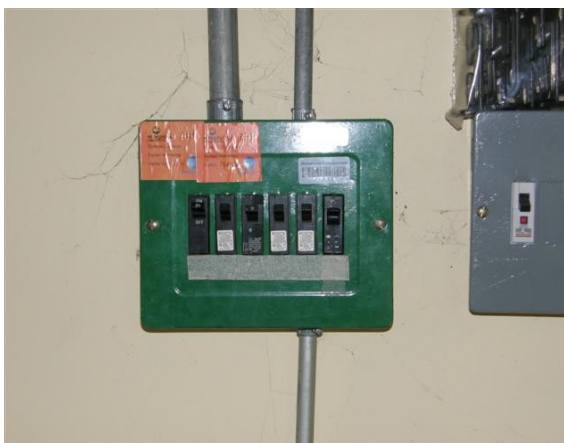
Caja de breaker de transmisores
