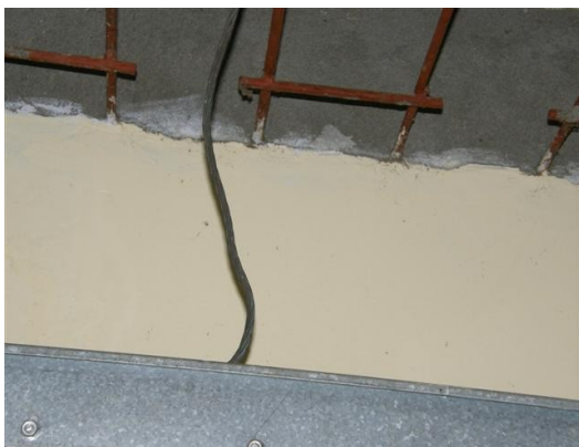
Cable de tierra al barraje del salón de equipos
