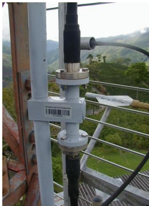
Distribuidor de antena panel
