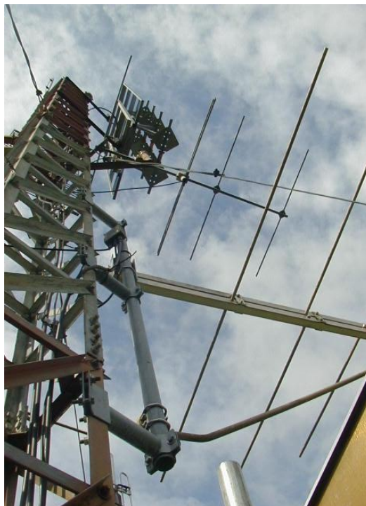
Antenas yagi y panel
