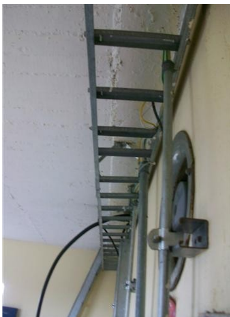
Escalerilla horizontal salón de equipos
