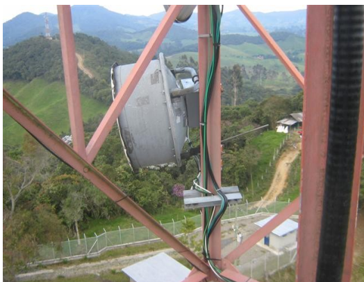
Antena microondas V2
