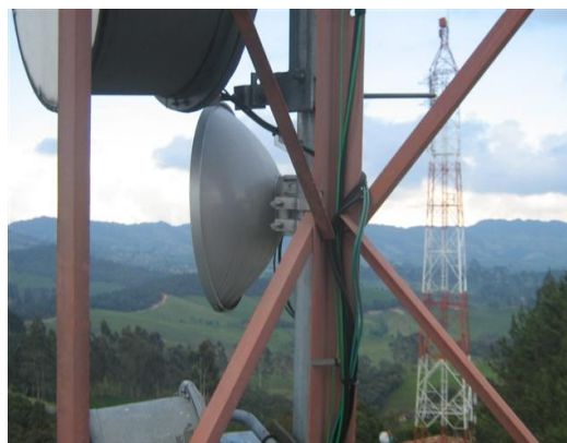
Antena microondas V2,
