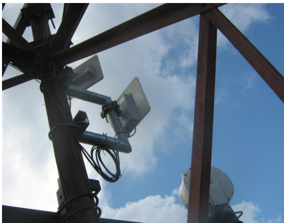
Antenas microondas
