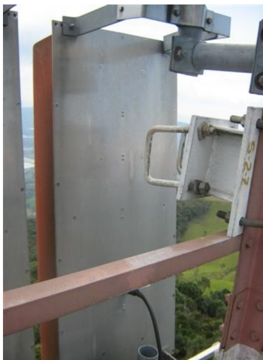
Antenas panel V1 T.V. RTVC
