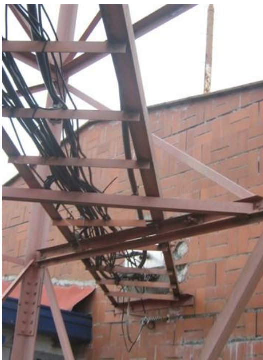
Escalerilla horizontal al salón de equipos
