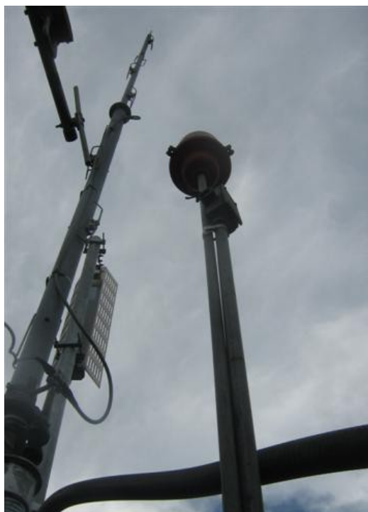
Antena F.M. y luz de obstrucción
