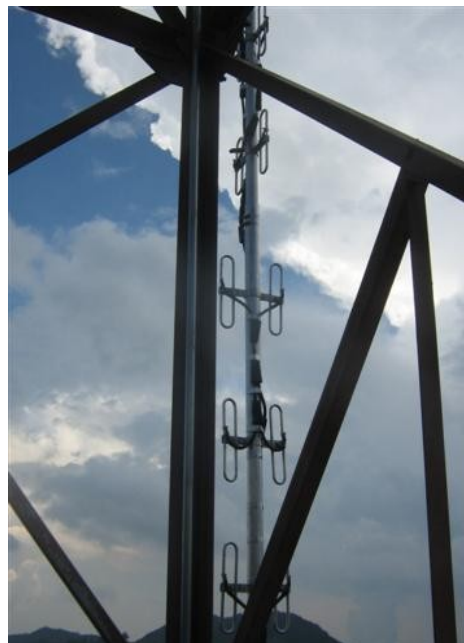
Antena omnidireccional
