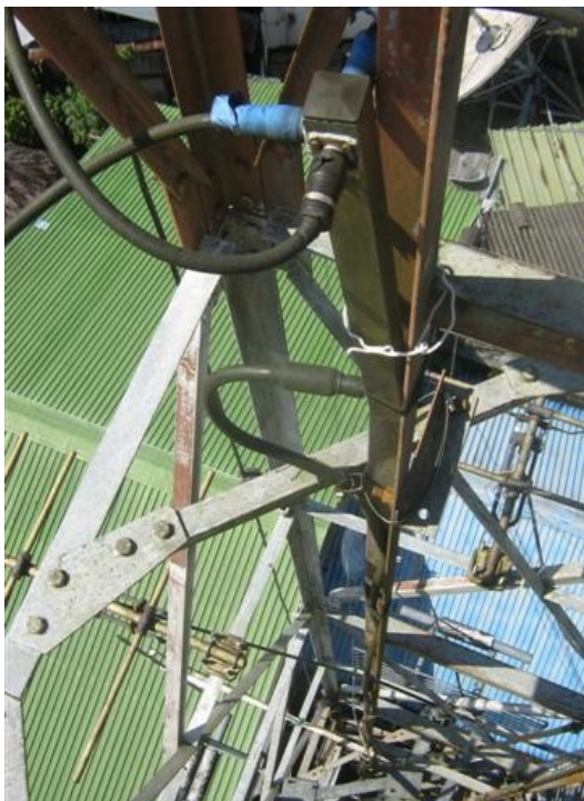
Distribuidor de antenas
