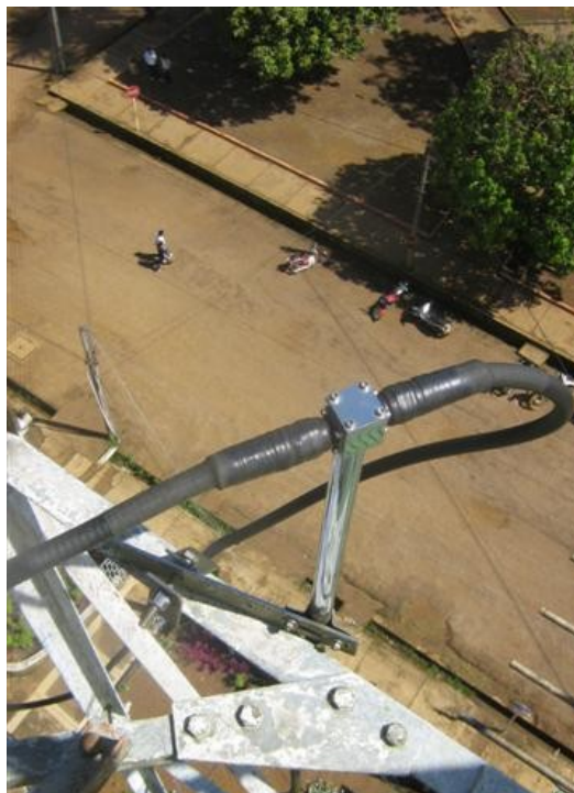
Distribuidor antenas
