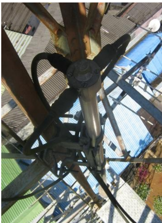
Distribuidor de antenas
