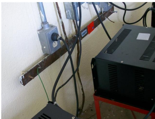
Barra de tierra salón de equipos
