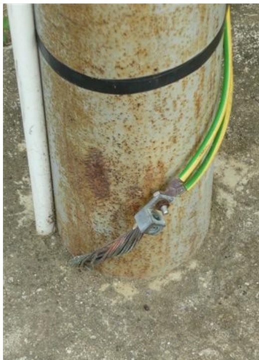
Sistema de puesta a tierra antena satelital
