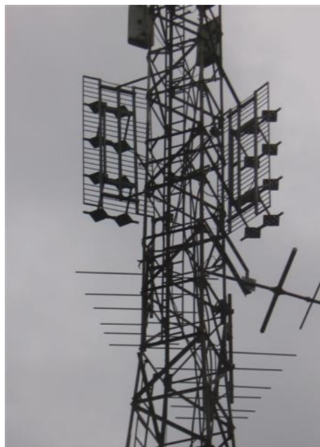
antenas panel 4 dipolos
