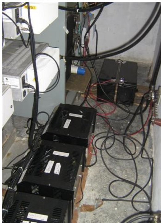
Reguladores y baterías de radio MOTOROLA
