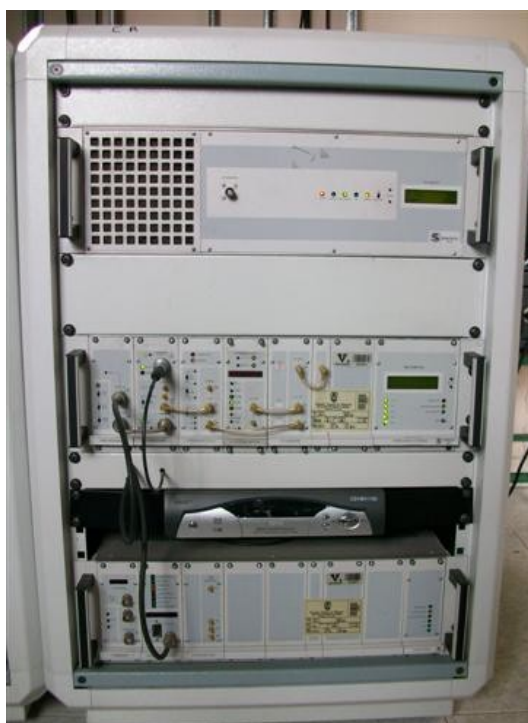
Amplificador, transmisor y offset SI
