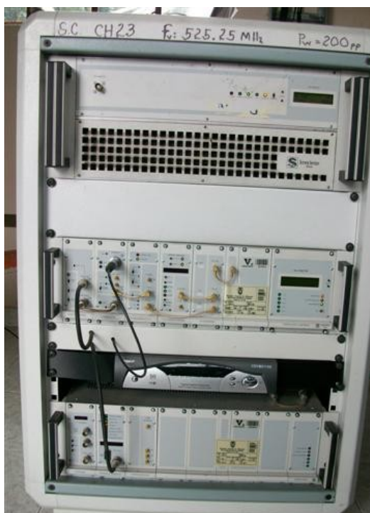
Amplificador, transmisor y offset SC
