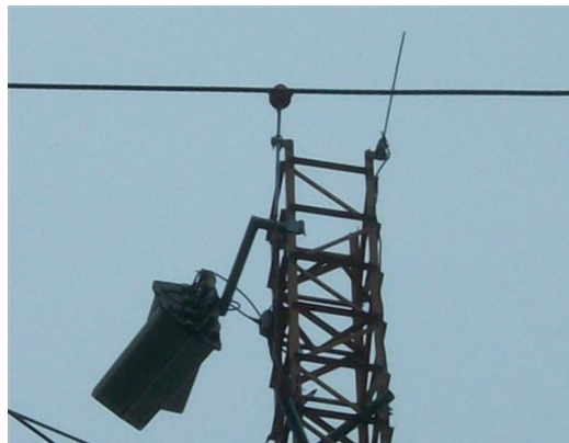
Antenas SC, pararrayos y luz de obstrucción
