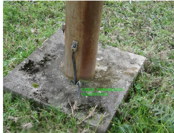
Puesta a tierra parabólica
