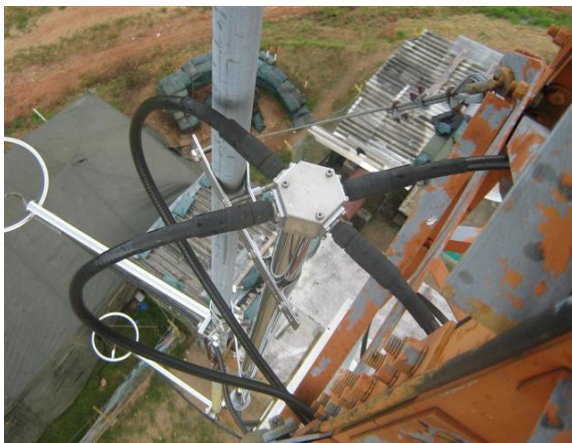
Distribuidor Antenas
