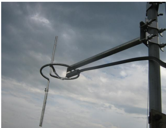
Antena Omnidireccional Cara B
