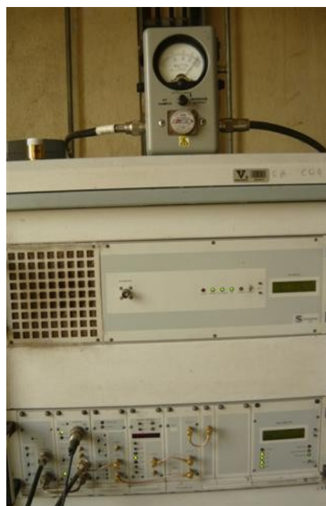
Medición potencia canal Institucional
